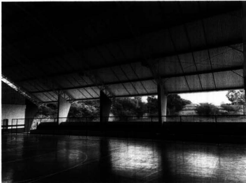
*Imagem 4 – Pintura da quadra com tinta epóxi e pintura da estrutura metálica.*
