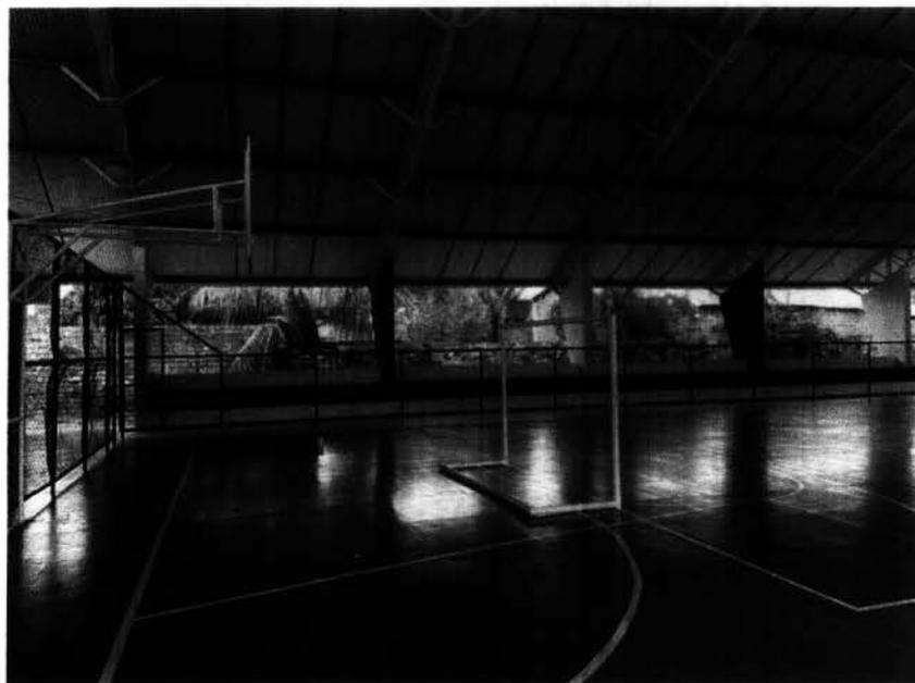
*Imagem 2 – Pintura da quadra com tinta epóxi e pintura de demarcação.*
